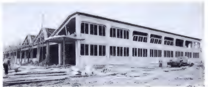
Neubau des Metz-Gehäuse- und Tonmöbelwerkes in Zirndorf
